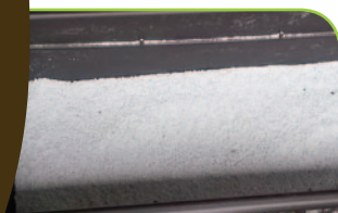
① Couche de 10 cm de substrat inerte, ici perlite
